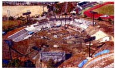
3月末完成へ向けて工事が進む三次市の新野球場
